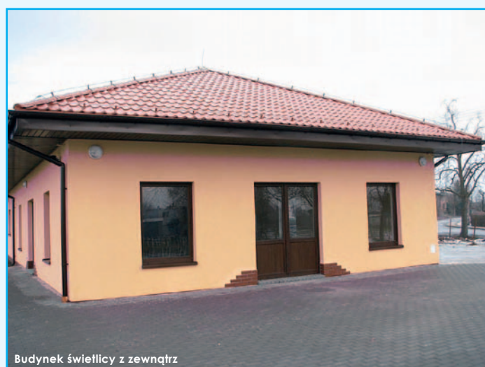
Budynek świetlicy z zewnątrz
